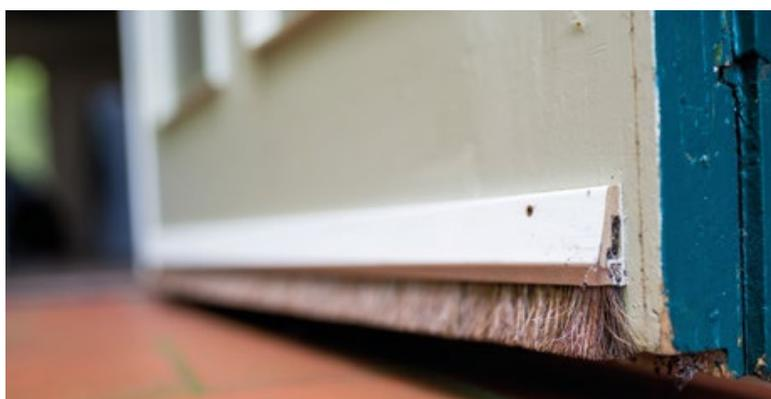
Durch Spalten und Ritzen zieht es und Wärme geht verloren – eine einfache Abdichtung vermeidet dies bei Außentüren.
