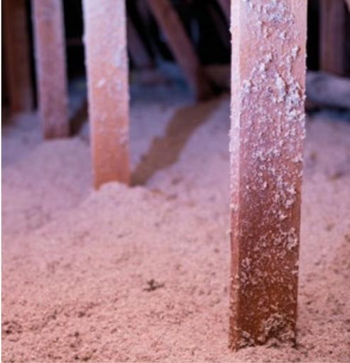
Eine einfache Einblasdämmung aus Zellulose auf dem ungenutzten Dachboden hilft dabei, dass die Wärme in den darunter liegenden Räumen bleibt.
