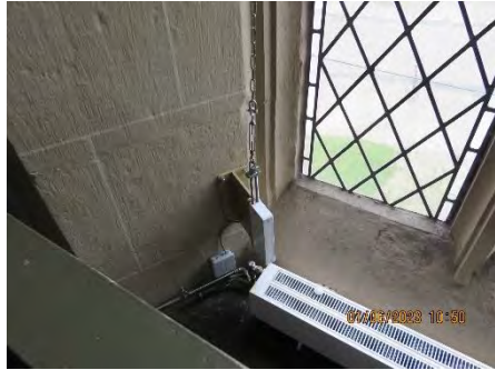
Fensterantrieb für autom. Lüftung
