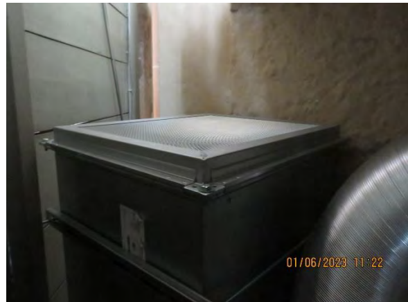
Abluftventilator für den Chor
