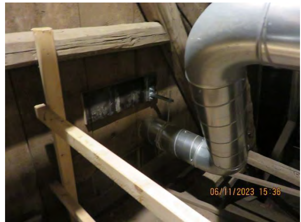
einer von 2 Abluftkanälen im Dachraum
