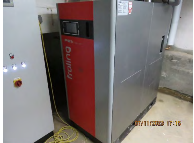
Pelletkessel fröling
