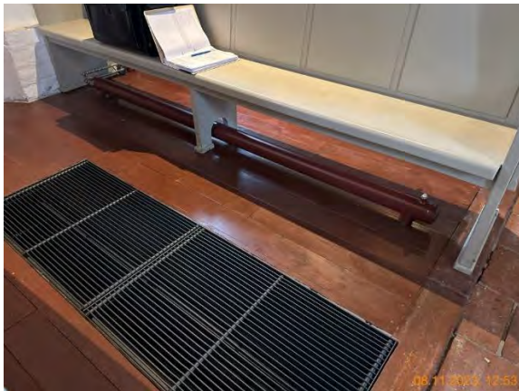
Wärmestation Kirchenbank-Rohrheizkörper
