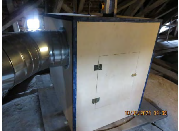
Abluftanlage im Dachboden Ansaugkasten mit Axialventilator Abluftöffnung im Engelsstein
