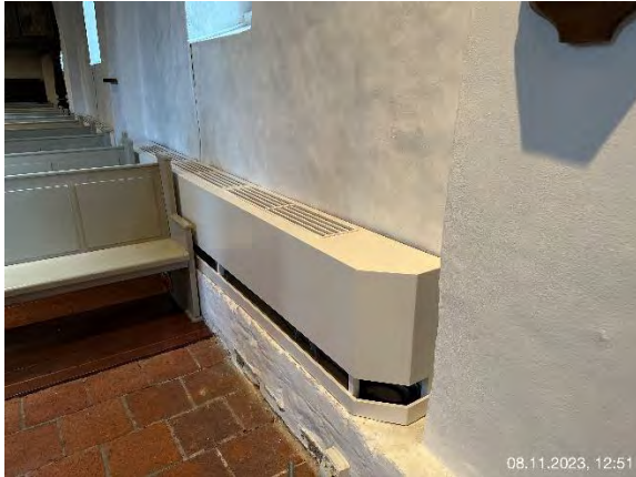
Oberflurkonvektor Kirchenbank-Rohrheizkörper
