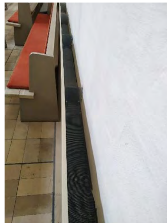
Oberflurkonvektoren Seitenschiff
