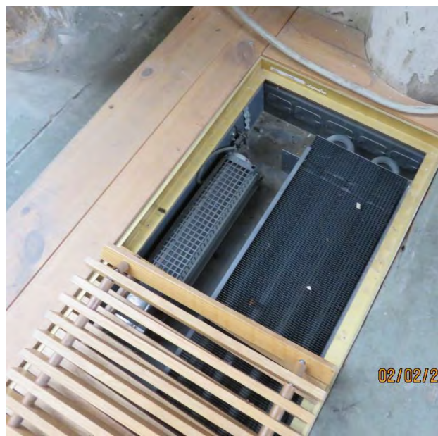
Unterflurkonvektor
