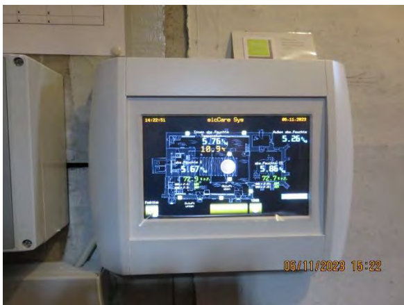
Bedienstation Lüftung (Passtec)
