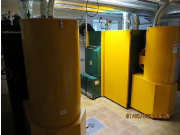
2 Pelletkessel Pelletfire Plus
