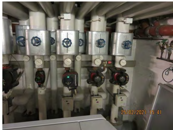
Heizkreisverteiler (Bestand)
