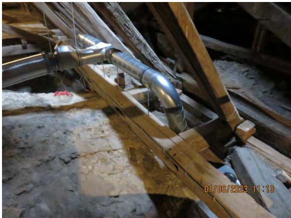
Abluftführung durch Löcher im Gewölbe
