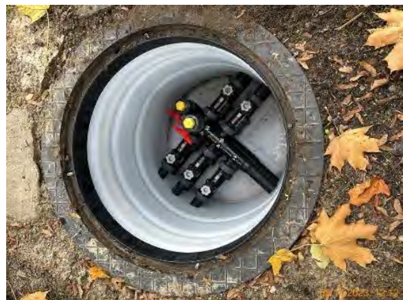
Erdsonen-Verteilerschacht
