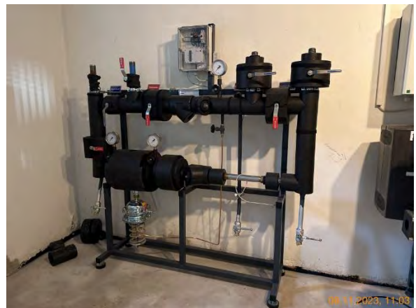
Fernwärmeanschlussstation (Primärseite)
