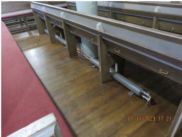
Bank-Rohrheizkörper
