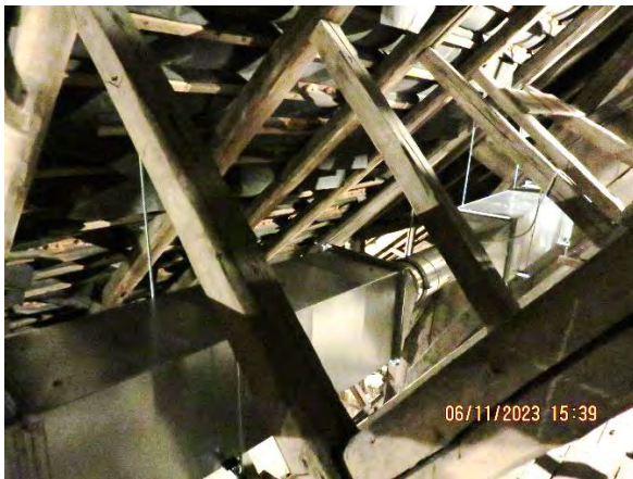
2 parallele Systeme: 2 Kulissenschalldämpfer und Abluftventilator
