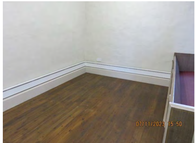
Thermofußleiste
