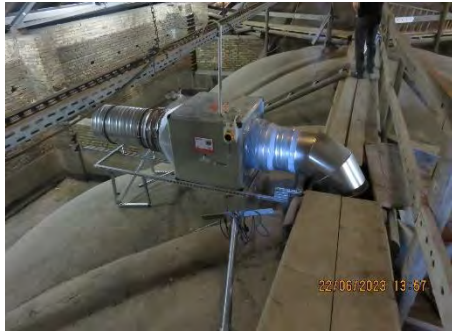
Abluftventilator im Dachboden
