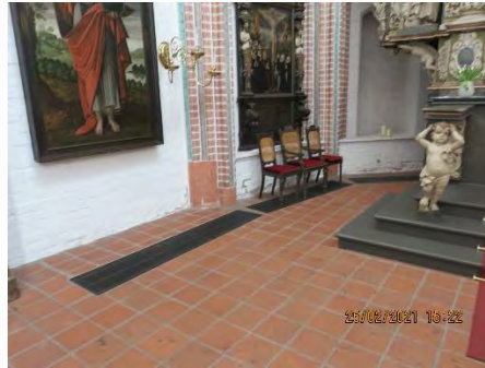
Unterflurkonvektoren (Bestand)
