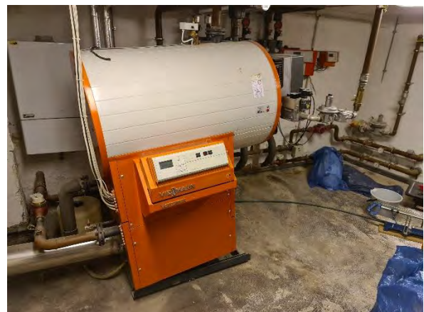
Gasheizkessel im Gemeindehaus mit Nahwärmeleitung zur Kirche (Bestand)
