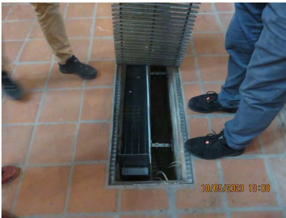
Unterflurkonvektor (Bestand)
