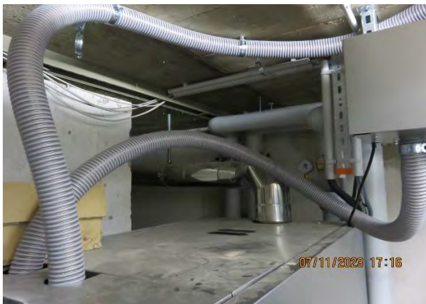
Pellet Ansaugsystem
