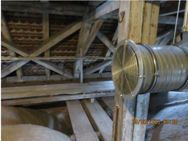
Luftauslass im Dachboden
