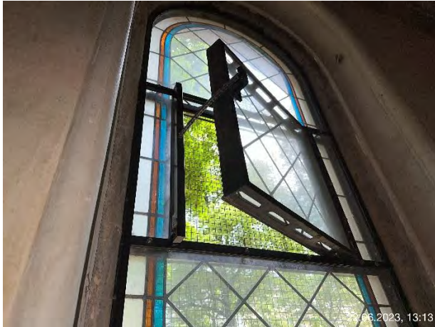
Fensterantrieb zur automatischen Lüftung
