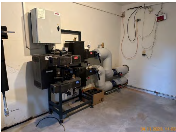
Fernwärmeanschlussstation (Sekundärseite)
