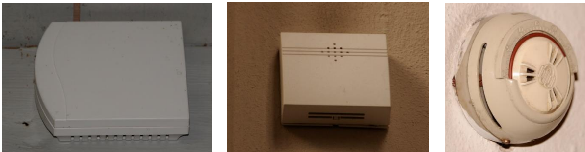
Abbildung 11: Einbauszustand von Sensoren links: auf Holzbalken, mitte: auf Stein/Putz, rechts: eingeputzt
